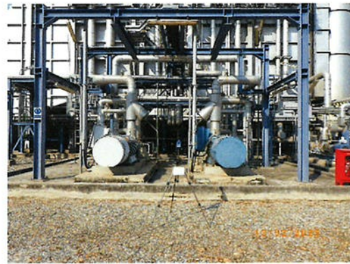
Boiler Feed Pump HRSG#11
